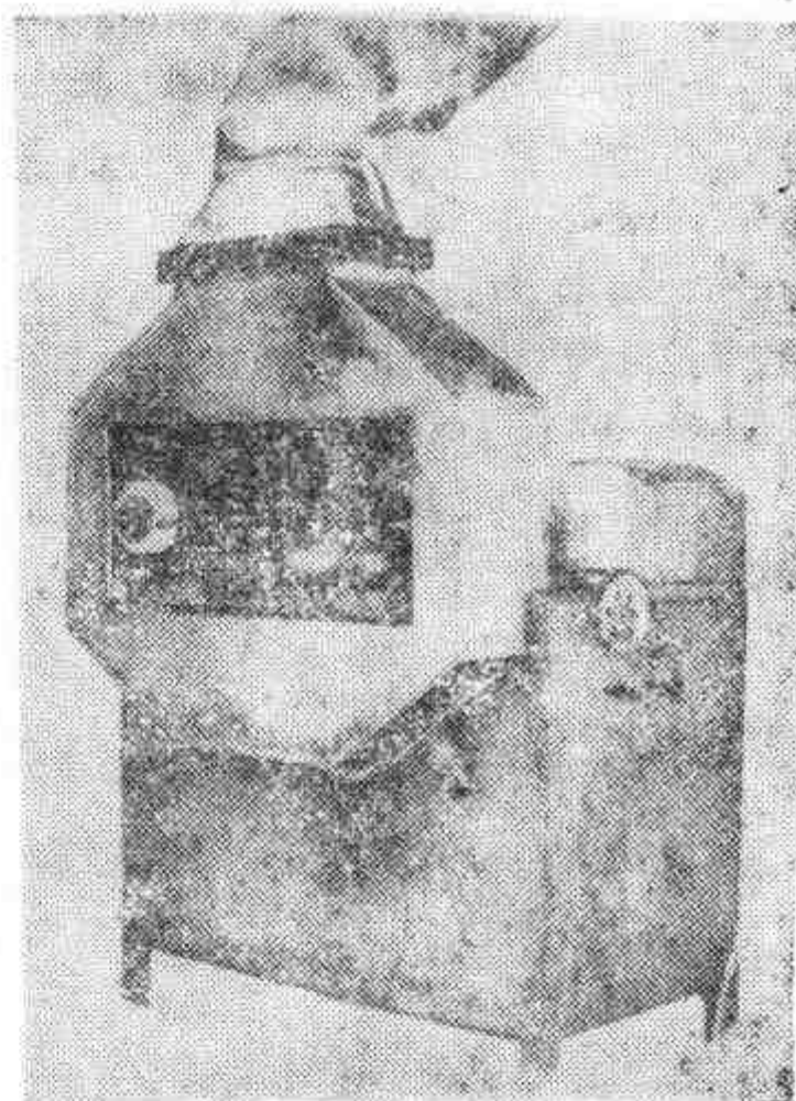
图 2-8-30 胶管磨胶机
